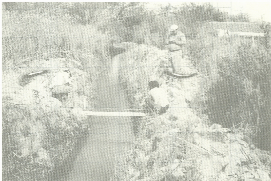
ESTACION SAN MANUEL SOBRE EL CANAL MARGEN DERECHA La estación y el tramo de aforos hacia aguas arriba.
